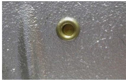
Gambar 20. Hasil pemasangan paku keling yang memenuhi standard
