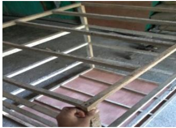
Gambar 5. kerangka kayu (kerangka bekisting)
