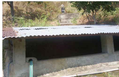
Gambar 3. Mataair, tandon air dan sumur bor di STA 2.
