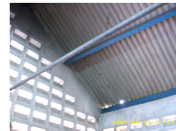
Atap Bangunan Tanpa Plafon
