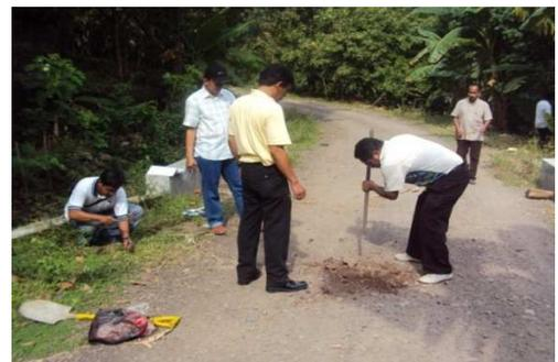
Gambar 12. Pengukuran ketebalan agregat kelas B bagian tengah. jalan (Simamora, 2010)
