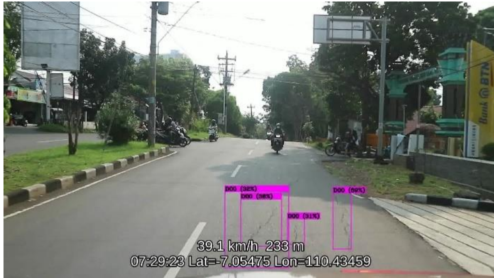
Gambar 4. Identifikasi kerusakan jalan dengan model yang dihasilkan
