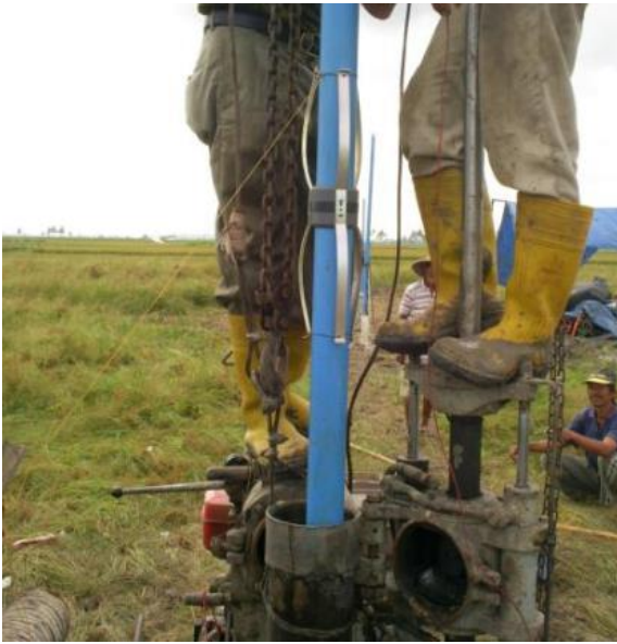
Gambar 4. Pemasangan pipa inklinometer dan spider magnet
