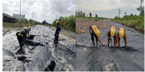
**Gambar 17.** Proses penggelaran dan penyambungan geotekstil diatas cerucuk
