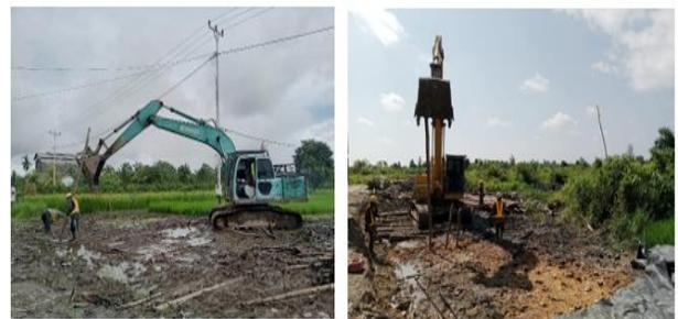
Gambar 15. Pemasangan cerucuk dan proses memasukkan hingga kedalaman tertentu
