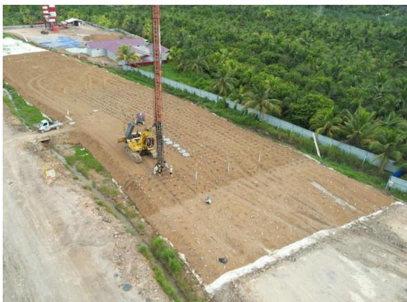
Gambar 3. Alat Rig untuk pemasangan PVD
