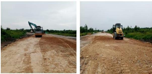
**Gambar 18.** Proses penghamparan menggunakan dozer dan excavator membetuk kemiringan serta pemadatan menggunakan vibro roller
