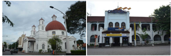
Gambar 5. Bangunan Konservasi di Kota Lama (dokumentasi, 2013)
