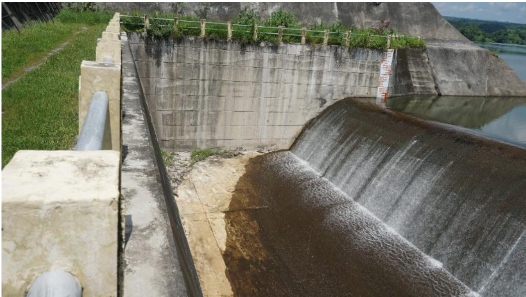
Gambar II.11 Bangunan Pelimpah Bendungan Bajulmati
