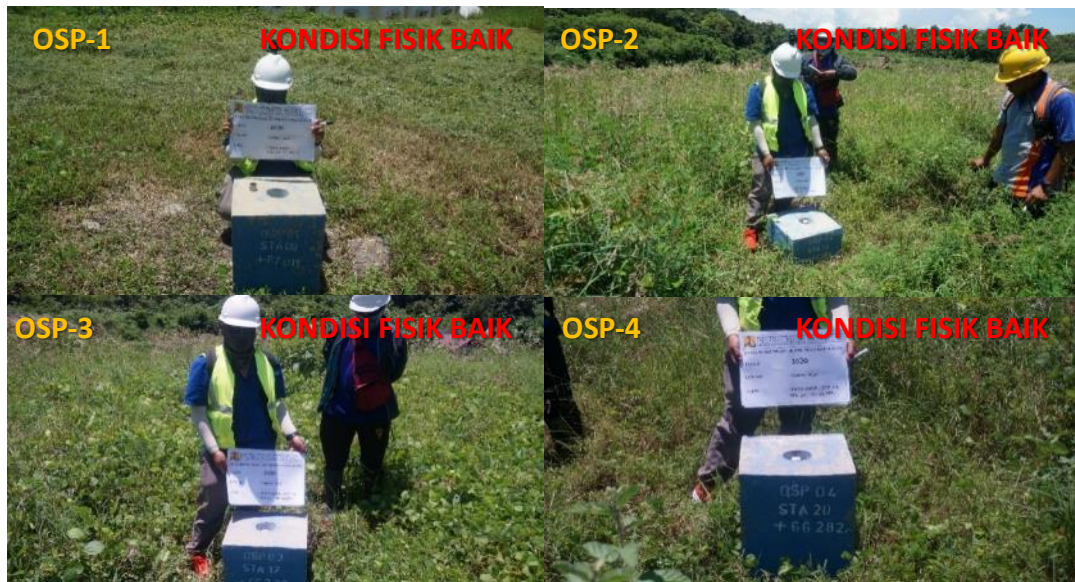
Gambar III-4 Kondisi Piezometer Open Standpipe Bendungan Bajulmati
