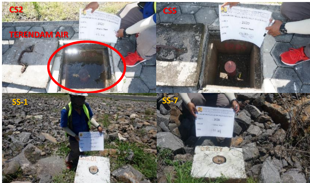
Gambar III-2 Kondisi Patok Geser Puncak dan Lereng Bendungan Bajulmati
