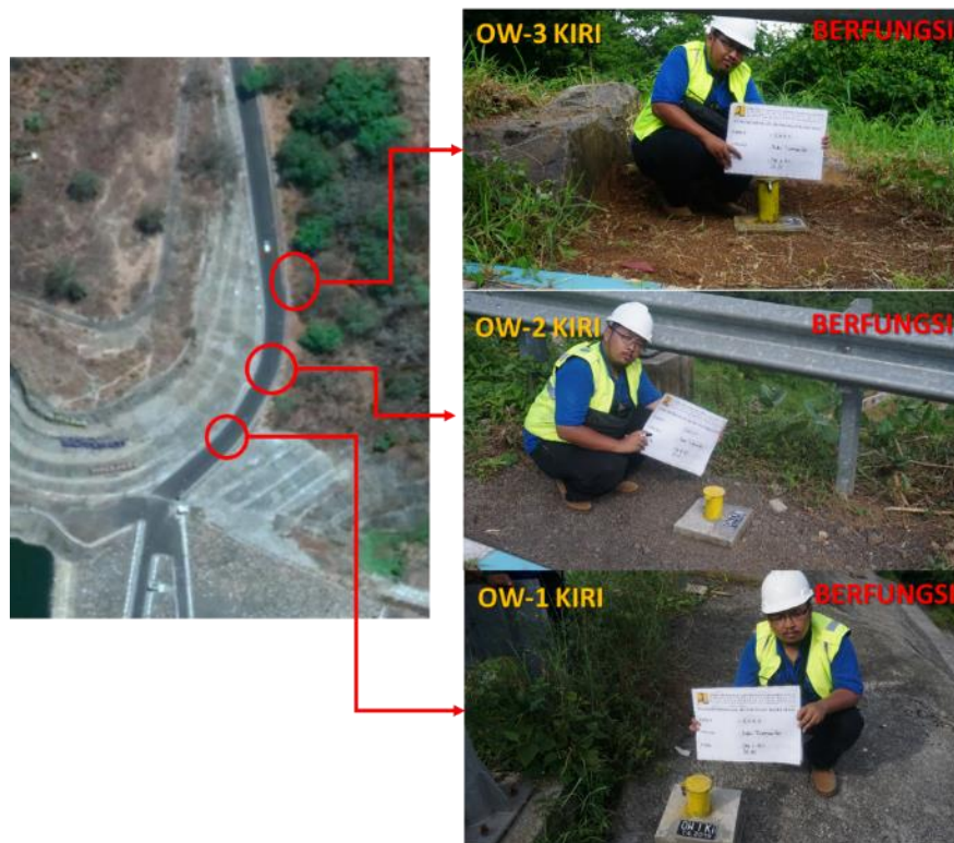
Gambar III-7 Kondisi dan Lokasi Pemasangan Observation Well Baru Bendungan Bajulmati
