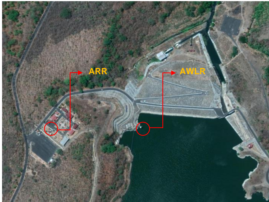
Gambar III-8 Lokasi Pemasangan ARR dan AWLR Bendungan Bajulmati
