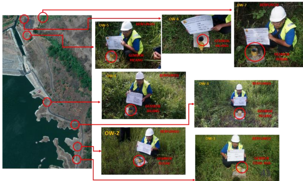
Gambar III-6 Kondisi dan Lokasi Pemasangan Observation Well lama Bendungan Bajulmati
