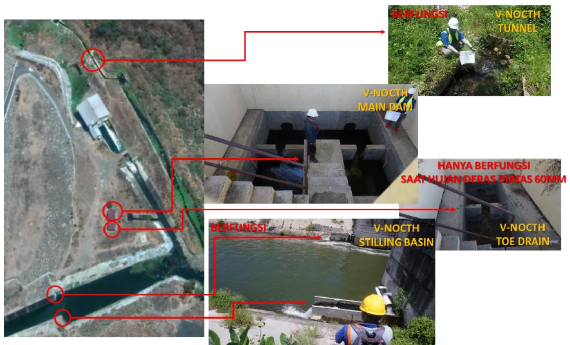
Gambar III-5 Lokasi Pemasangan V-Notch Bendungan Bajulmati
