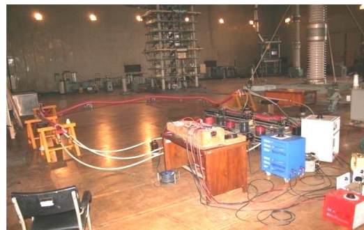
Gambar 12. Rangkaian Pemanasan Kabel TM dengan menggunakan Current Transformer dengan posisi kabel ditekuk dan diposisikan dalam 1 loop
