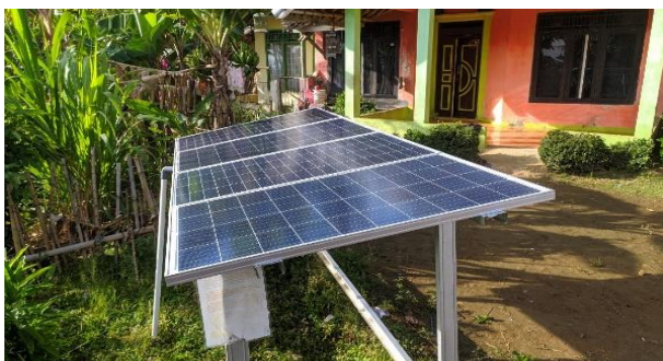
Gambar 1. Tampak samping pemasangan panel surya
