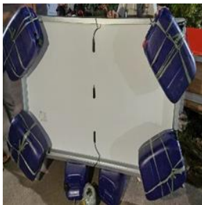
Gambar 9. Proses Pemasangan Jerigen Sebagai Media Pelampung PV
