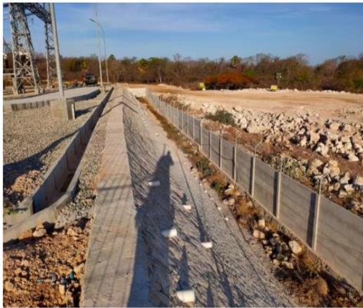
Gambar 3. Proyek pembangunan disekitar gardu induk
