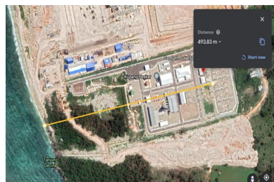
Gambar 2. Lokasi gardu induk dari bibir pantai
