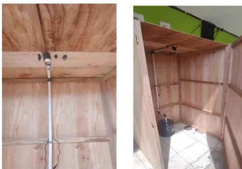
Gambar 21. Pemasangan Pipa dan Sprinkler Pada Kotak Ruang Simulasi
