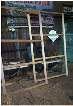
Gambar 19. Kotak Ruang Simulasi Menggunakan Rangka Tulang Kayu
