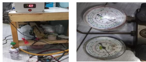
a. Penambahan Freon b. Pengecekan Tekanan
