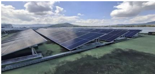
Gambar 1. Sistem PLTS On-Grid Tanpa Baterai (Kondisi Eksisting)
